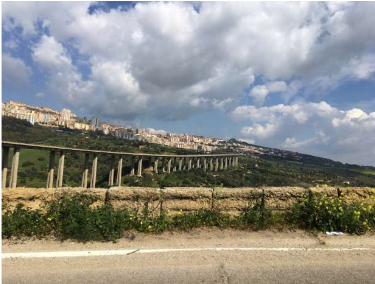
Viadotto Morandi (AG)
